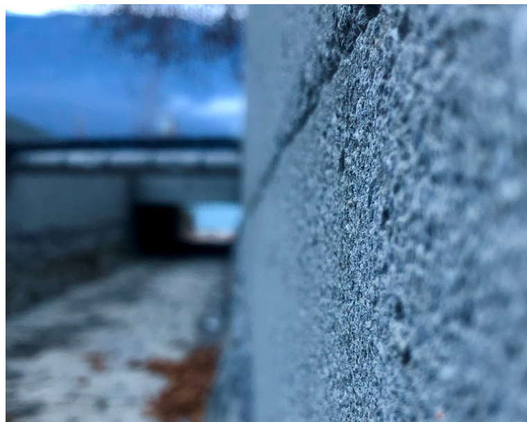
Entfernung Bojake auf Beton von Hochwasserschutz
