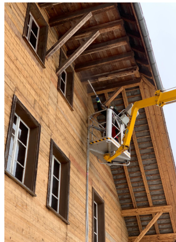
Trockeneisstrahlen
