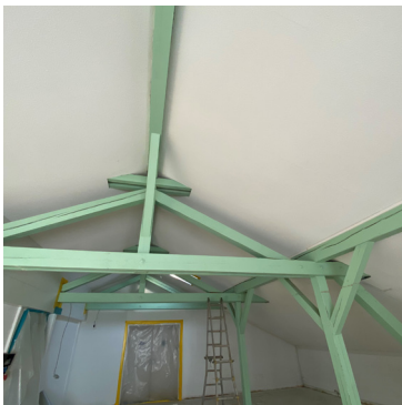
Konstruktion Dachgeschoss – vorher
