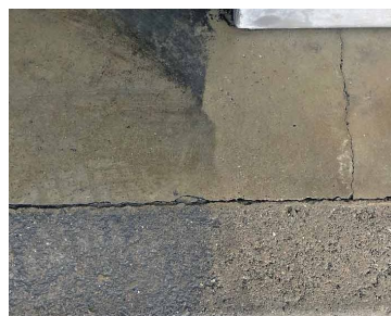
Entfernung von Ölrückständen auf Beton bei Tankstelle
