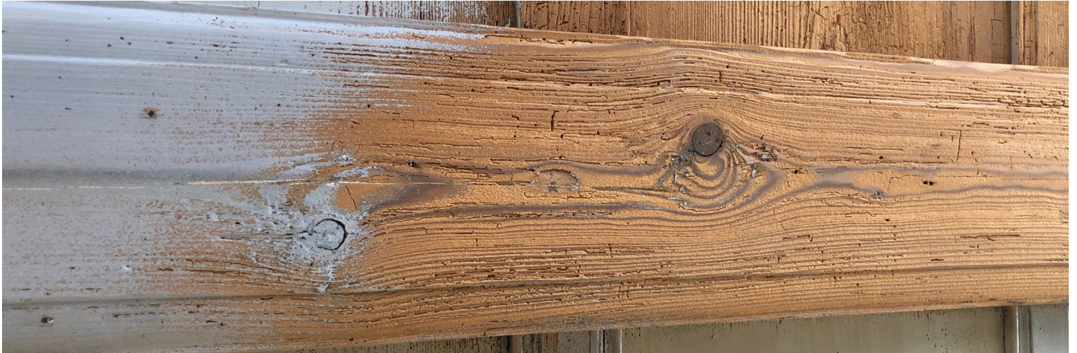
Decke sandstrahlen
