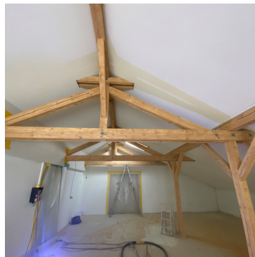
Konstruktion Dachgeschoss – nachher
